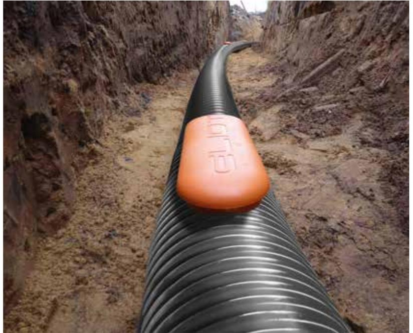
**Terrendis® + Eliot®: un système de canalisations pré-isolées "intelligent" équipé de puces RFID qui en permet la localisation et l'identification avec une précision de l'ordre du cm et ceci jusqu'à 2,5 m de profondeur.**
