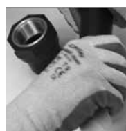
PRÉPARER LES SURFACES AVEC LE CLEANER+
