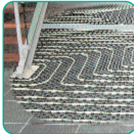
Chauffage par le sol
