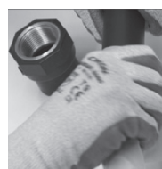
PRÉPARER LES SURFACES AVEC LE CLEANER+
